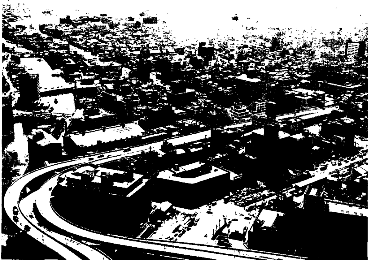
טוקיו: קטע של כביש-המכוניות הראשי, המחבר את נמל-התעופה הכיון-לאומי עם תרכזה העיר (ארכו 21 ק"מ)
